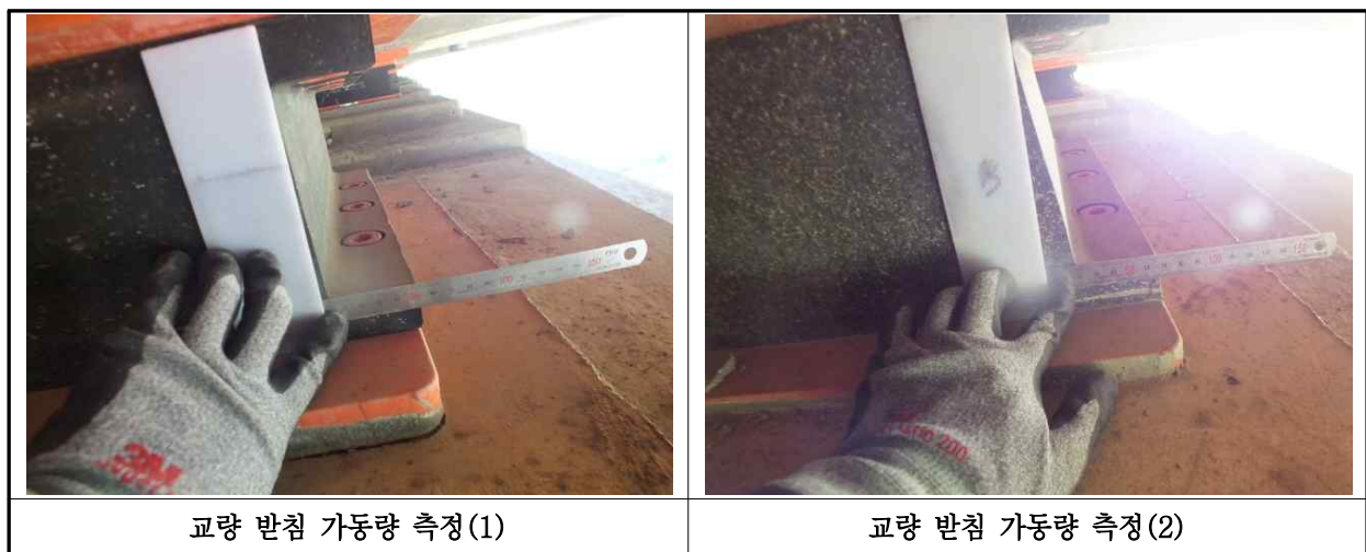
【사진 34.3.38】교량받침 이동량 측정
