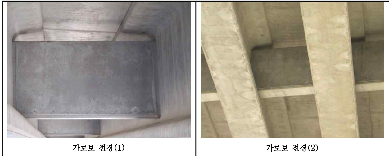
【사진 34.3.29】 가로보 전경
