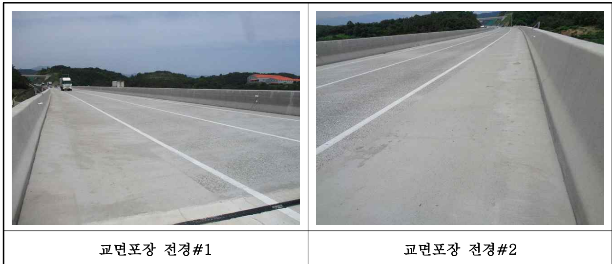
【사진 34.3.42】 교면포장 전경
