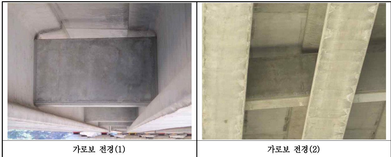
【사진 34.3.6】 가로보 전경
