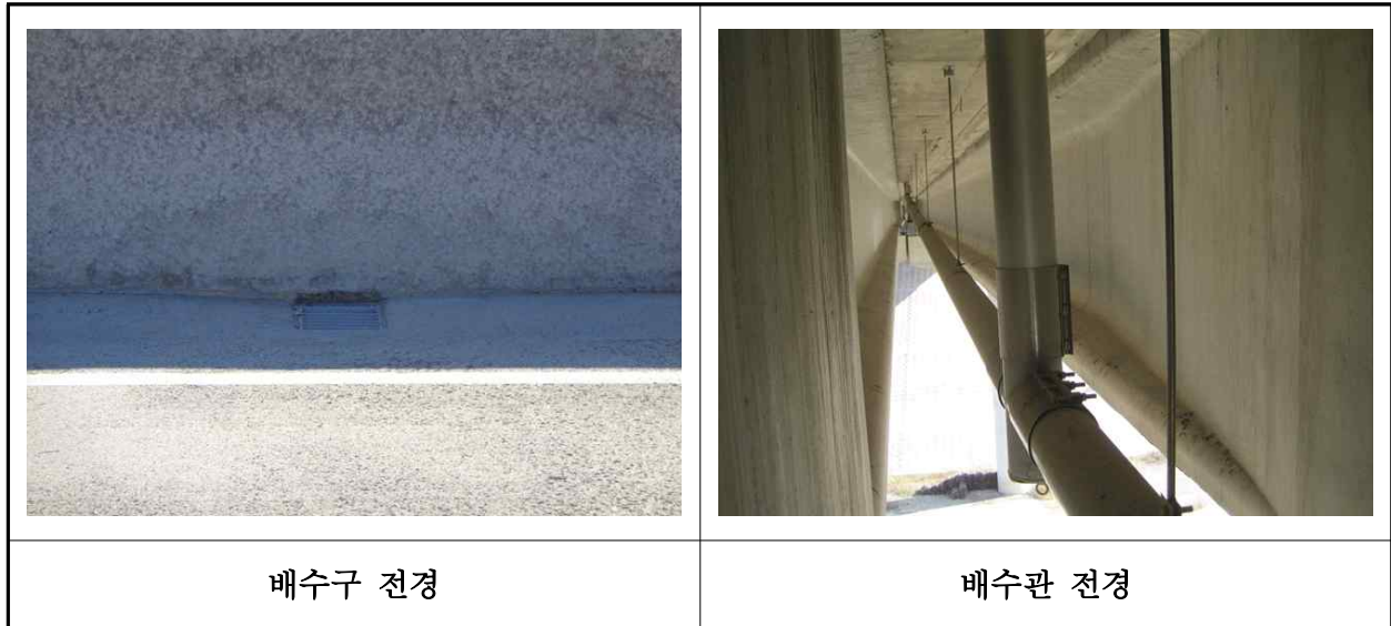
【사진 34.3.21】 배수시설 전경
