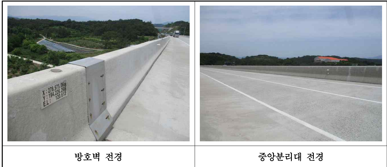
【사진 34.3.46】 방호벽 및 중앙분리대 전경
