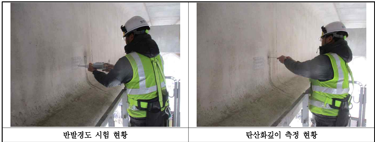
【사진 34.4.1】 콘크리트 내구성조사 현황
