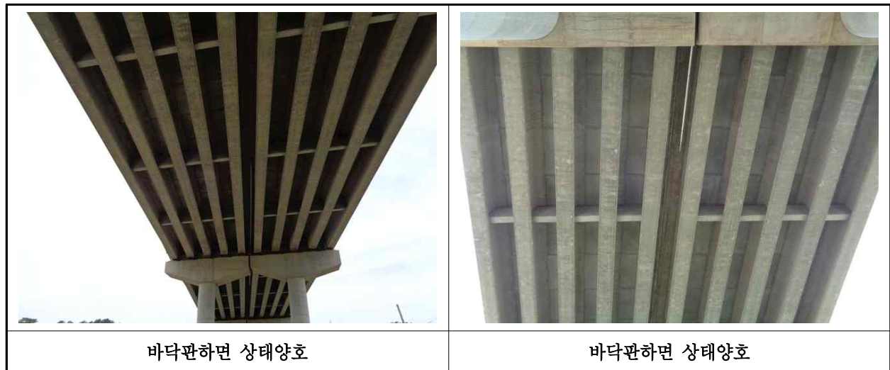
【사진 34.3.3】 바닥판하면 손상현황
