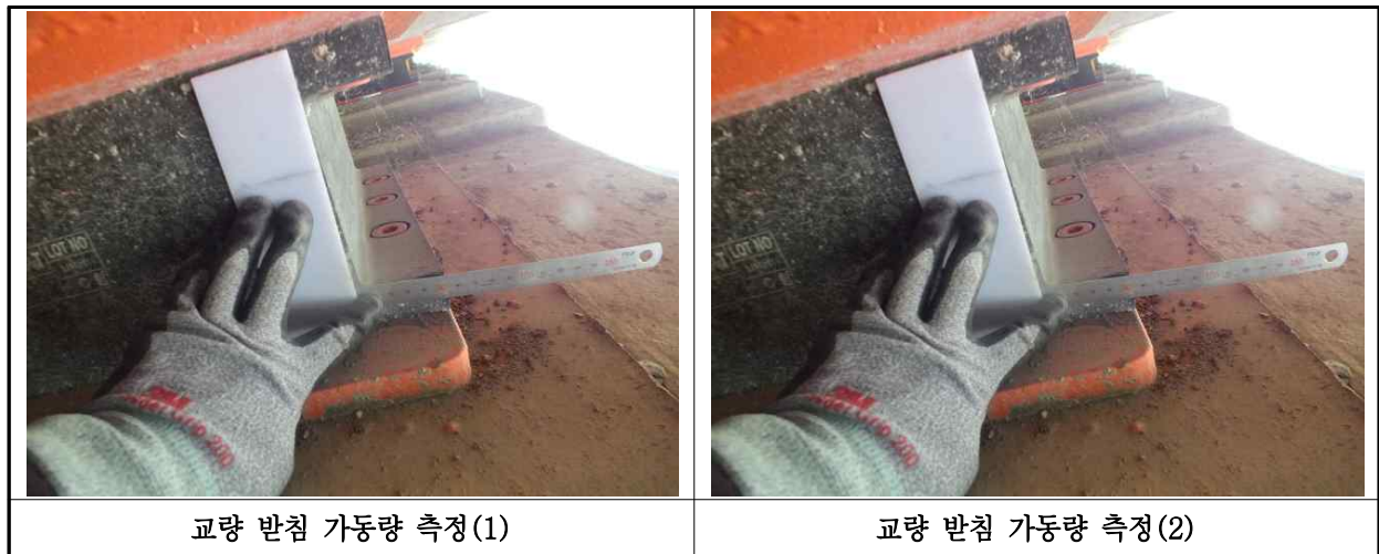
【사진 34.3.15】 교량받침 이동량 측정
