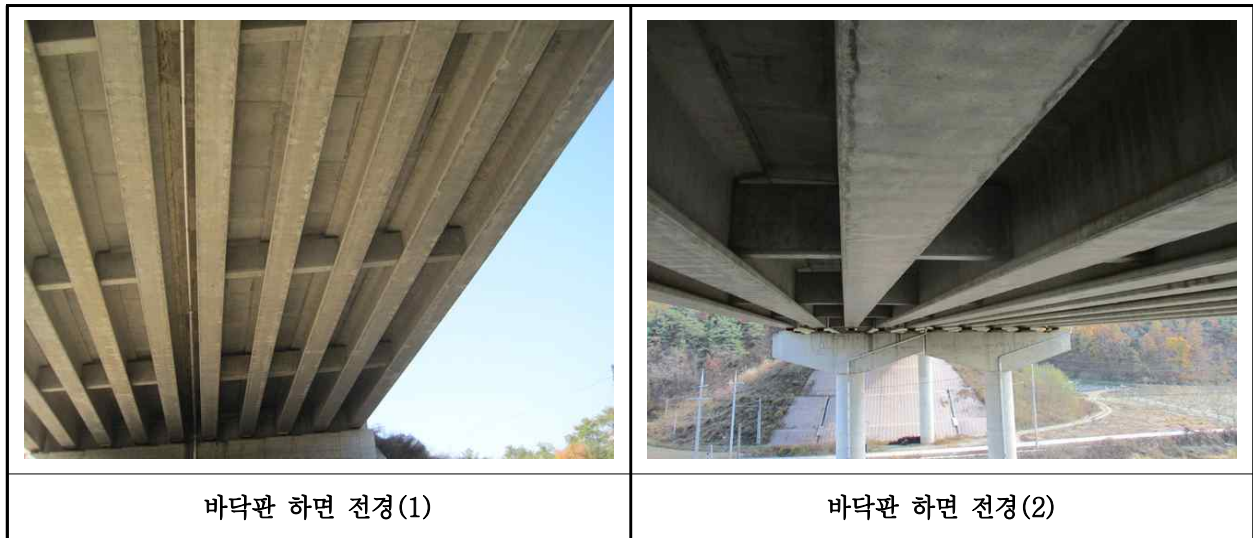
【사진 34.3.2】바닥판하면 전경
