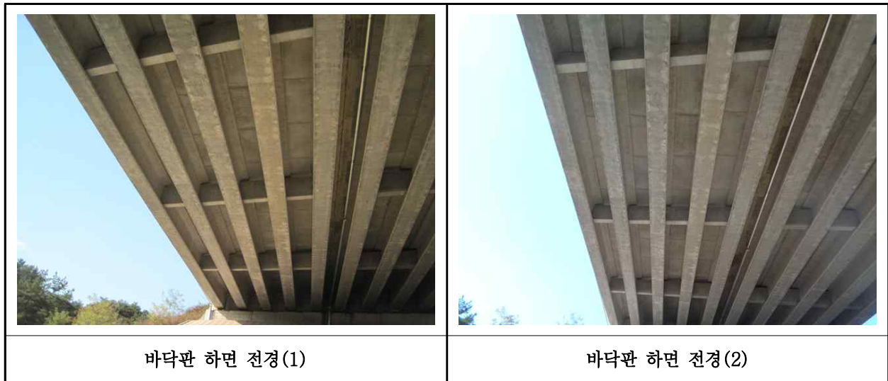
【사진 34.3.25】 바닥판하면 전경
