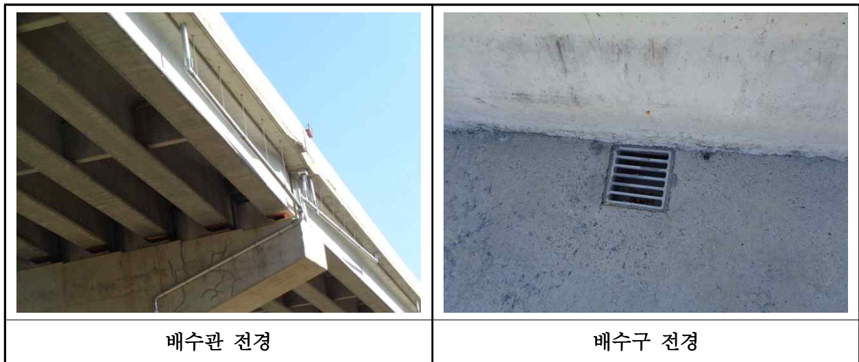
【사진 34.3.44】 배수시설 전경
