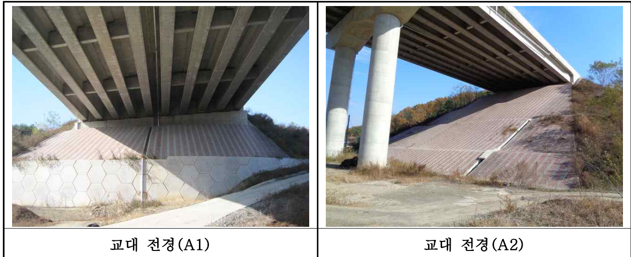
【사진 34.3.31】 교대 전경
