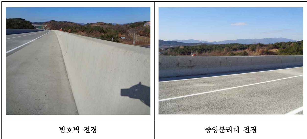
【사진 34.3.23】 방호벽 및 중앙분리대 전경
