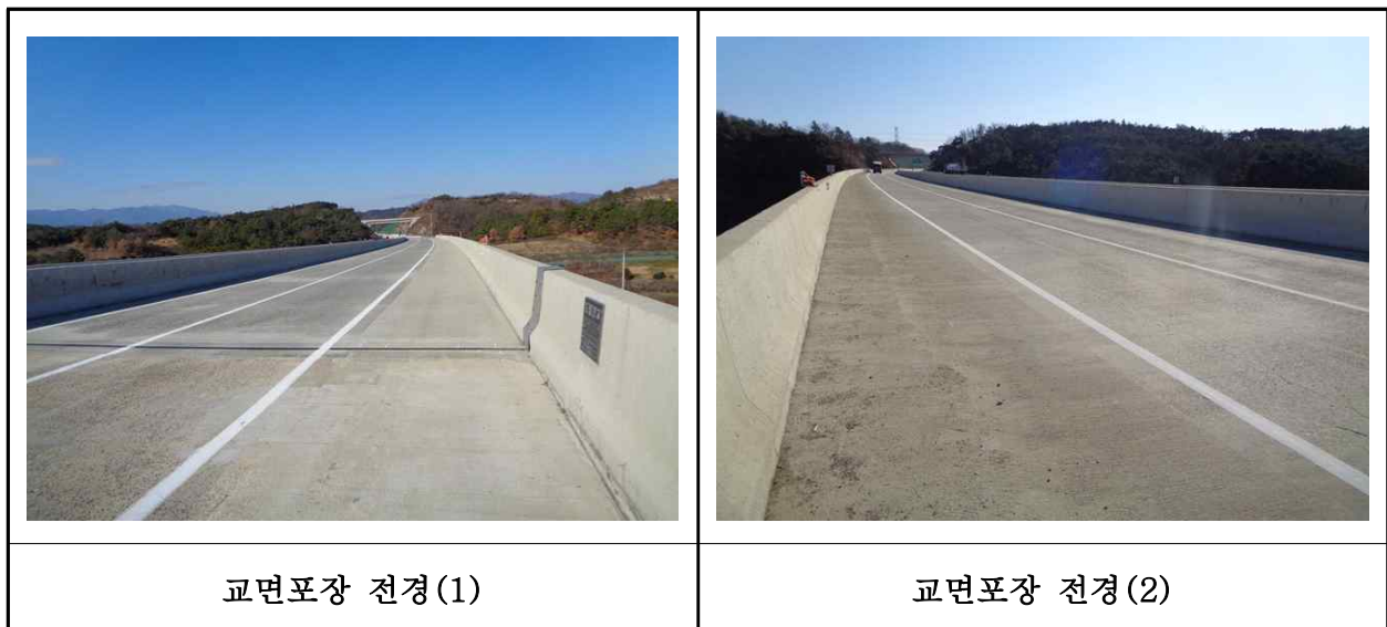
【사진 34.3.19】 교면포장 전경
