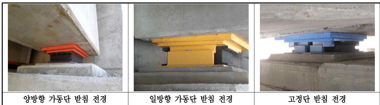
【사진 34.3.12】 교량받침 전경
